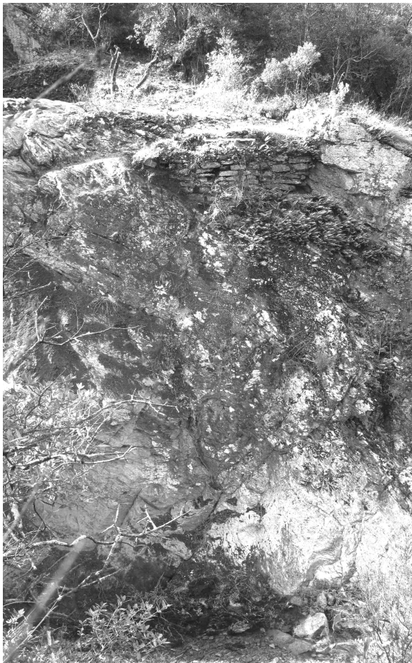
Cliché Enllaç 18 : Projet Enllaç 2012, Les Cluses, Rom III, restes antiques du parapet de la via Domitia au-dessus de la Rom. (cliché Jérôme Kotarba, Inrap)
