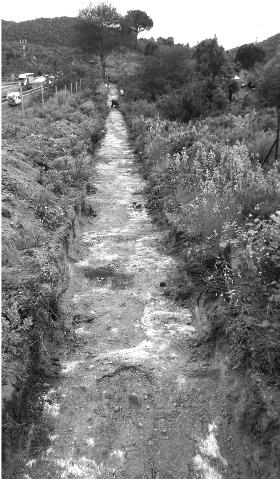
Cliché Enllaç 8 : Projet Enllaç 2012, Le Perthus, Camp de la Torre, tranchée le long de l'A9. (cliché Guillem Castellvi)
