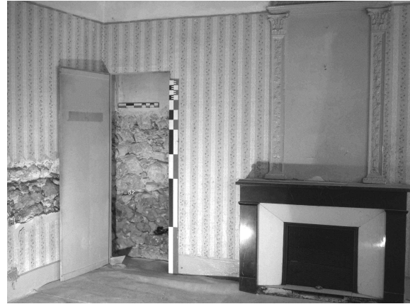
Figure 3 : Prades, 5 rue des marchands, pente de toit de la première phase, 1er état (cliché C. Jandot)
