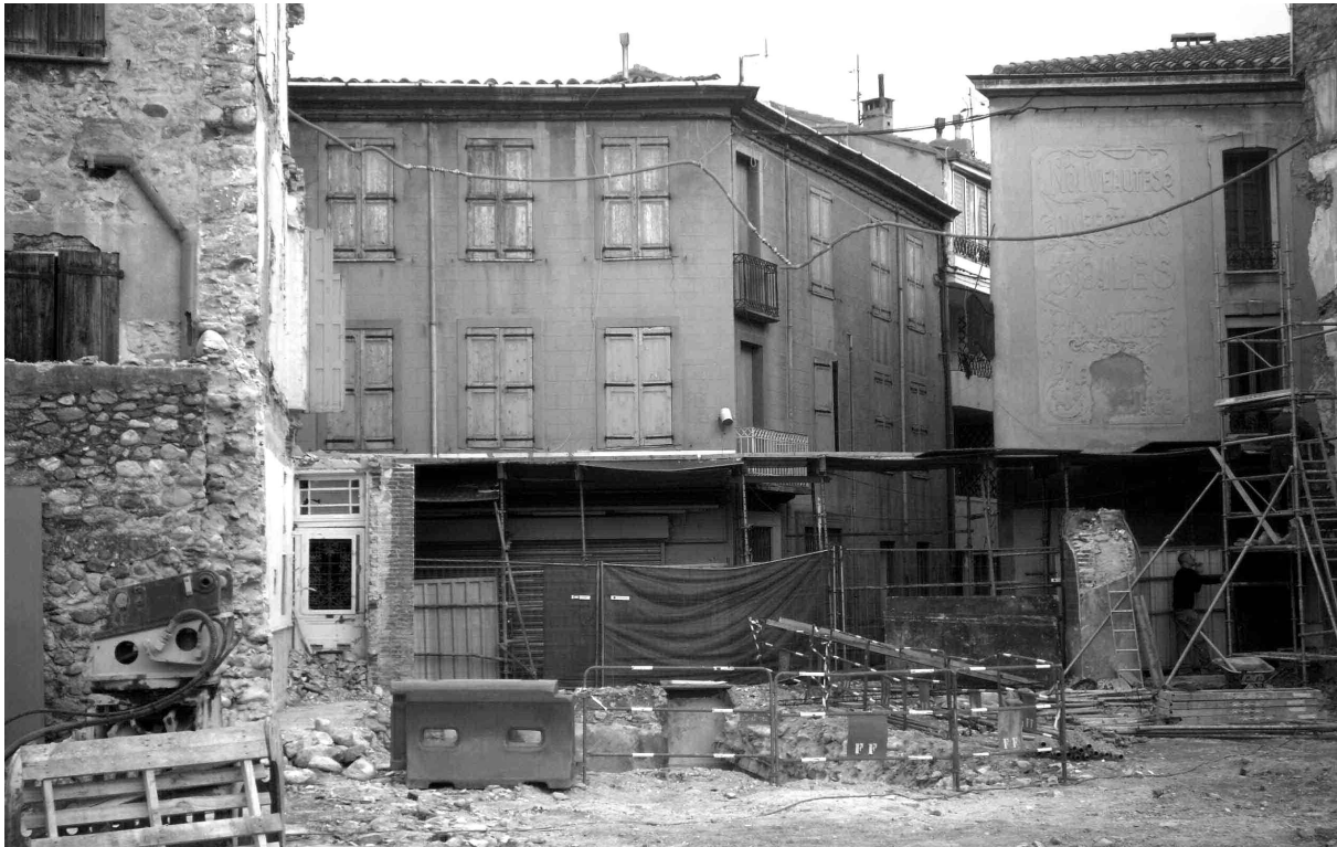
Figure 1: Prades, 5 rue des marchands, vue générale (cliché C. Jandot)
