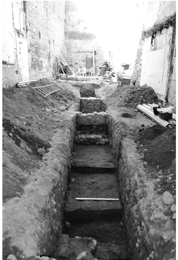
Fig. 1 : Tranchée du 61 Route Nationale (cliché : PAD / Conseil Général des P.-O.)
