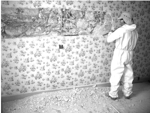
Figure 2 : Prades, 5 rue des marchands, réalisation d'un sondage par Denise Lafitte (cliché C. Jandot) Jandot)
