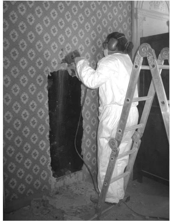
Figure 2: Prades, 22 rue des marchands, sondage au marteau-burineur (cliché C. Jandot, Inrap)
