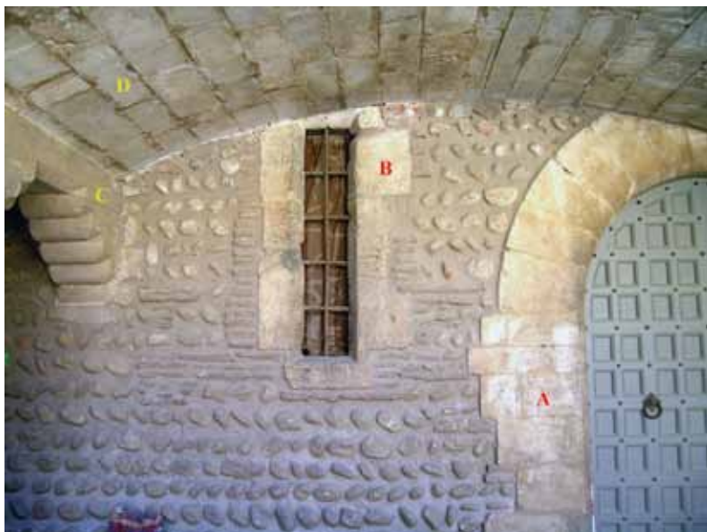
16 - Portail B11 en marbre blanc de Baixas (A) sous l'escalier sud de la grande cour (D). Au-dessus du mur en galets typiques d'une phase ancienne du chantier se trouve une fenêtre (B), elle aussi recoupée par la voûte, mais taillée dans un calcaire tendre et blanc, du type « pierre du lac ». En C, l'une des piles de l'escalier en grès siliceux du Boulou.
