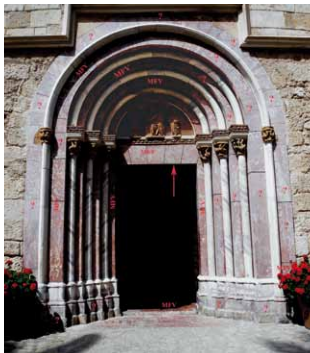
57 - Portail de la chapelle Sainte-Anne, au palais de l'Almudaina, à Palma de Majorque, avec sa légère levée de seuil et son curieux linteau en plate-bande appareillée sous le tympan (flèche rouge). Les points d'interrogation indiquent les parties du marbre rouge dont la tonalité violette tranche avec le reste, surtout à la base du portail.
