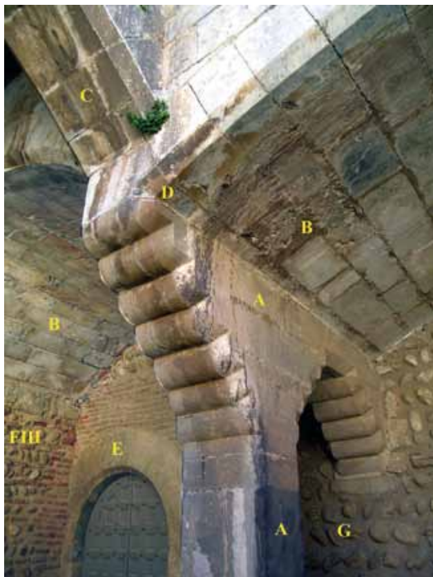
12 - Pilier de l'escalier sud de la cour d'honneur en grès siliceux du Boulou avec ses avancées typiques en tas de charge (A). Ce pilier reçoit la poussée des voûtes de l'escalier en marbre de Baixas (B), gravées de minuscules signes lapidaires, et celle des voûtes basses de la galerie des chapelles (C), ainsi que celle du pilier de la galerie haute, juste au-dessus. Le sommier (D) est en marbre de Baixas, comme la porte E, visiblement antérieure au mur FIII de séparation des cours. On remarquera la différence entre les murs anciens montés en galet (G) et le plus récent (FIII) munis de chaînage de briques.
