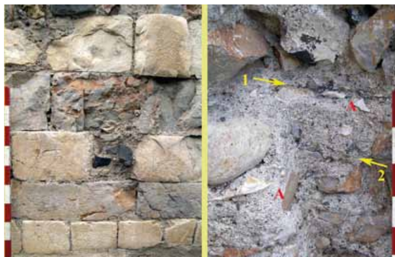
28 - Église romane ancienne d'Espira-de-l'Agly, détail de l'architecture en bandes bicolores sur l'extérieur (vue de gauche où l'on remarque la belle qualité du marbre blanc saccharoïde et celle, médiocre, du calcaire bleu, très fissuré). Vue de droite les éclats de marbre blancs (flèche n°1 et A) et bleus (flèche n°2) pris dans le mortier de chaux à l'intérieur de l'abside.
