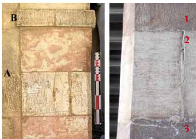
59 - Portail F5 de la cour d'honneur. À gauche, le montant nord avec les parties layées sur le tailloir (B) et bouchardées (A, décrochement pour l'enduit). À droite les claveaux de la voûte layés à la gradine (1, 2) ou avec un taillant à bretture? (3) - (cl. C. Respaut, AAPO).
