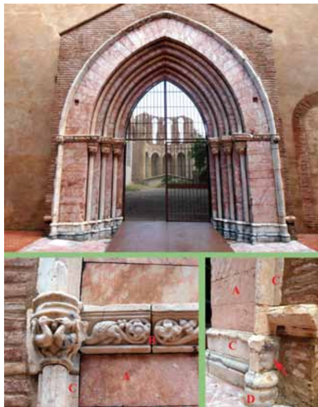
46 - Portail de l'église des Carmes à Perpignan. En bas, détails qui montrent la recherche d'une difficile homogénéité des couleurs pour les marbres rouges compacts du Conflent (A) et les marbres blancs du bassin de Tech (B, quelques taches noires sur les oiseaux affrontés), ainsi que l'utilisation de la « brèche romaine » de Baixas (C, avec une flèche pour indiquer une grosse adhérence bleue à la base du pilastre) et de la « brèche orientale » bleutée (D) (cl. C. Respaut, AAPO).
