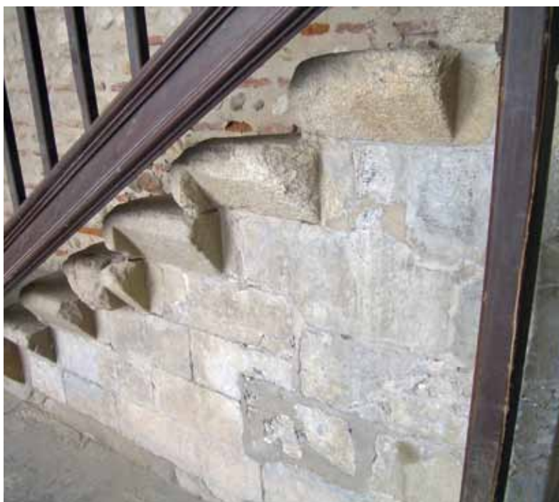
9 - Escalier S2 de la cour de la reine dont l'embranchement est en granite des Albères et sous lequel se trouvent de nombreux signes lapidaires gravés sur les brèches de Baixas.
