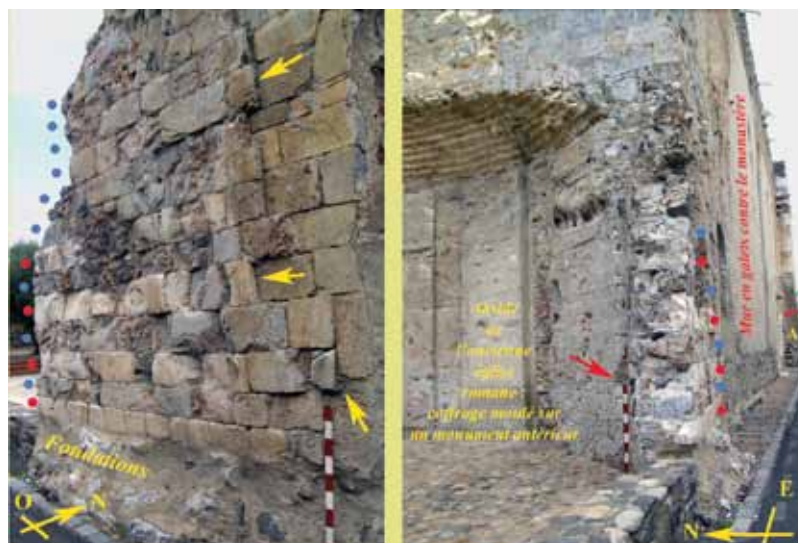
27 - Église romane ancienne d'Espira-de-l'Agly, à l'angle sud-ouest de l'église fortifiée. À gauche, assises bicolores au bas du mur méridional (les points rouges indiquent le marbre blanc, les autres le calcaire bleu); les flèches jaunes signalent le décrochement entre le mur ancien et le plus récent, près d'une ancienne porte murée (les deux édifices n'ont pas strictement la même orientation cardinale). À droite, vue intérieure du négatif du chevet (béton de chaux), la flèche rouge indiquant la présence des lits d'éclats de taille. Sur la droite au fond (A), le début d'une arcade en marbre blanc de l'ancien cloître, précédant le décrochement de la façade de l'église fortifiée où se trouve le portail principal.
