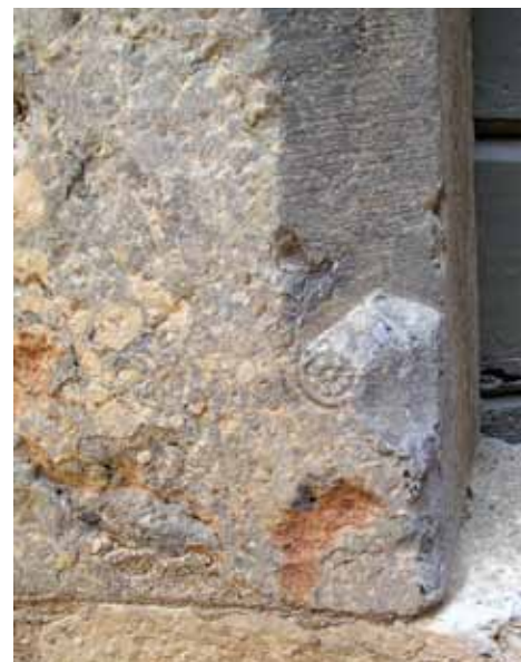
17 - Congé de chanfrein délicatement sculpté d'une petite rosace sur la porte H6 de la cour de la reine qui ne livre pas de signes lapidaires. Le matériau est ici le plus sombre de la « brèche orientale » de Baixas, dressée à la gradine dont on voit les traces en négatif sur le chanfrein.
