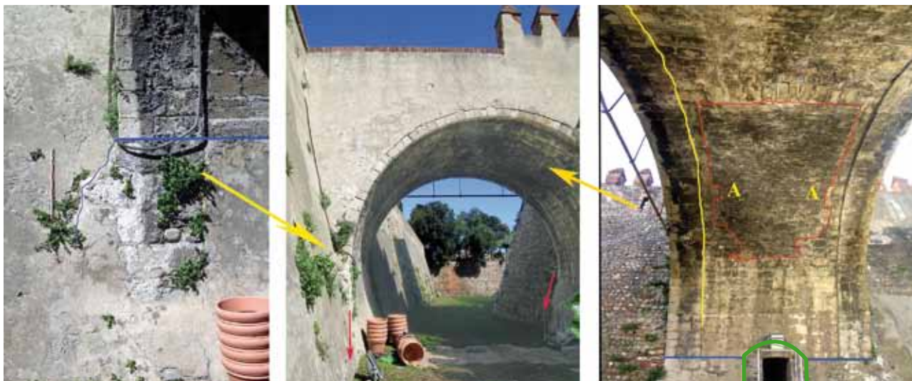
13 - Vues du pont-levis en avant de la courtine, depuis le fossé (au centre, les flèches rouges indiquent le pendage des chaînages de la culée et ceux du pilier, à gauche). Sur la vue de droite, prise en dessous, le trait bleu matérialise la partie basse, faite en marbre de Baixas, le trait jaune une des deux arches construites séparément avant la voûte et le trait rouge l'évidement comblé avec de la brique pour le pont-levis en bois. L'existence d'une avancée des parements qui encadrent le vide (A) suggère la présence d'un axe pour un possible pont basculant, pas forcément encastré au-dessus dans le portail du porche. L'existence sur le pont d'un passage piéton possible de chaque côté du vide explique que le parapet venait en biais buter de part et d'autre sur cette limite pour bloquer cet accès, ce qui est visible sur les photos de 1945, avant restauration (Alazet 2005, p. 72 et Martzluff et al. , cet ouvrage, ill. 5). Le passage souterrain qui fait communiquer la barbacane avec le fossé (encadré en vert) est post-médiéval (escalier en briques peu usées, blocs de basalte en remploi dans les murs).
