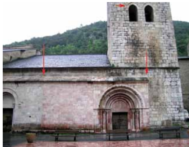
49 - Église de Villefranche où (grâce à la pluie) apparaît nettement, entre les deux flèches verticales, le mur gouttereau nord de la première église et son portail, monté avec du marbre rouge pour l'essentiel. La différence est nette avec les élévations postérieures, vers le second portail (à gauche) et sur le clocher-tour. Là fut réservée une modeste place à un marbre rosâtre pour la voûte des baies en tiers-point (flèche horizontale), le reste étant bâti en roches cloisonnées du type « FP » aujourd'hui ternies. L'origine des marbres bien rouges qui composent le pavage de la place est étrangère au substrat local.
