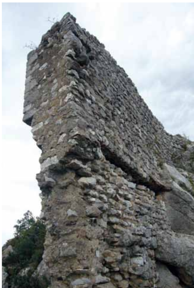
8 - Point n° 20 : dernier état de la forteresse avec un curieux retour vers la corniche occidentale de la courtine établie à l'extrémité nord de la fortification ; on remarquera l'appareillage de petits moellons équarris au têt et l'ancrage du toit en tuiles d'une maison à étages édifiée juste à l'endroit où passe le chemin vicinal actuel (cliché A. Catafau).
