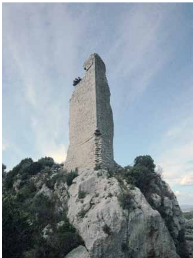
5 - Point n° 13 : éperon nord du château majorquin, fossé au premier plan. Le chaînage d'angle (restauré) avait été épierré à la base; on remarquera juste au-dessus le départ d'un chanfrein sur l'angle et le curieux décrochement à l'aplomb dans le mur de gauche (cliché A. Catafau).
