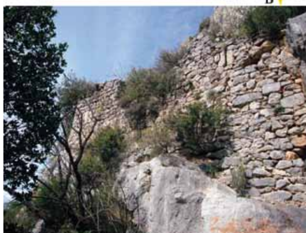
9 - Remparts donnant sur le versant oriental : la courtine haute est remaniée à gauche (détail en A) et de même facture à cet endroit que celle percée de meurtrières en aval (détail en B) (cliché A. Catafau).
