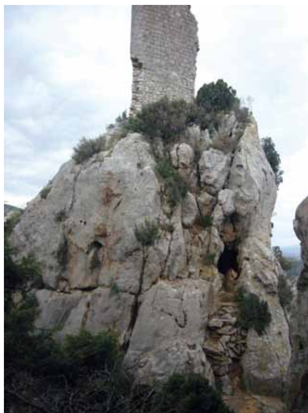
10 - Boyau du réseau karstique constituant une faiblesse sous l'éperon nord de la forteresse majorquine ; à droite, la brèche en partie naturelle recoupée à sa base par l'exploitation moderne en carrière et la paroi occidentale nappée d'enduits stalagmitiques (cliché A. Catafau).
