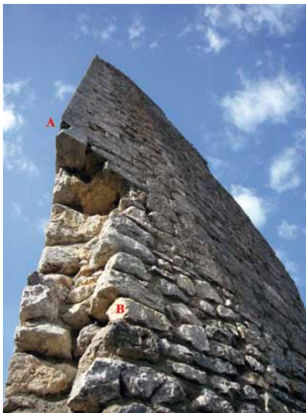
11 - Jeu subtil d'un « angle gras » pour adapter le mur de cet éperon au substrat ; on remarquera que le début du chanfrein (A) est oblique, l'ancrage de l'« angle maigre » s'avancant au delà de la partie restaurée (B) (cliché A. Catafau).
