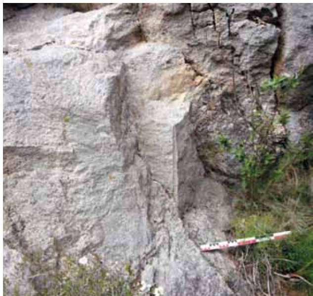
17 - Point n°14 : hémisphère négatif de barre à mine et traces caractéristiques de brisure de la roche à l'explosif (cliché A. Catafau).
