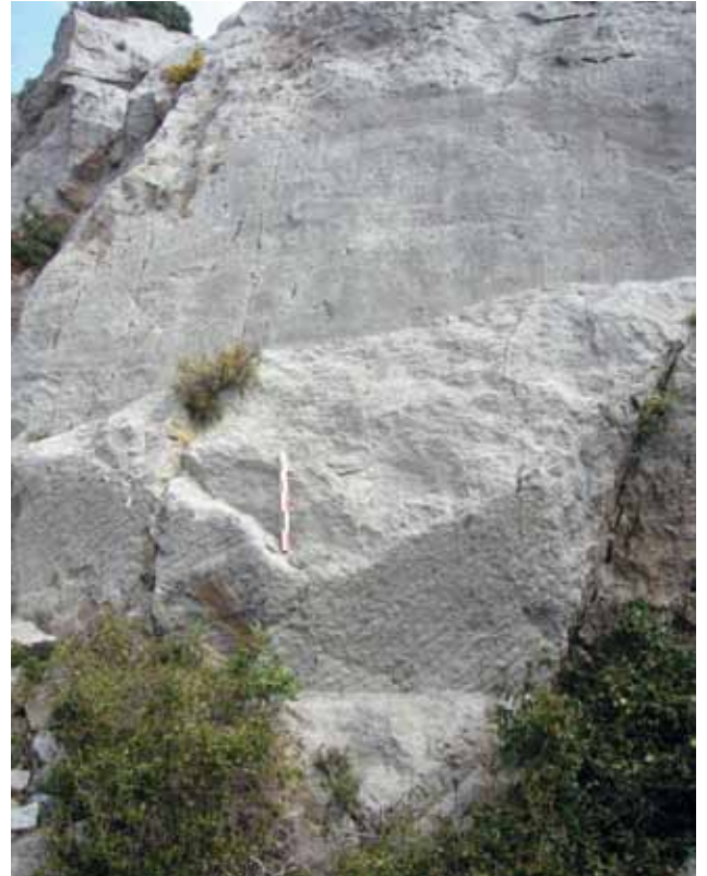
14 - Point 14 : en haut les vestiges de creusements médiévaux entaillés en V et très érodés ; en bas, sous la mire, les traces sub-verticales de creusement au pic d'époque moderne (cliché A. Catafau)..
