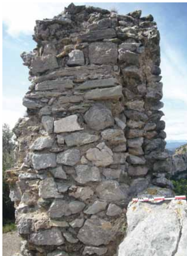
7 - Point n°17 : tronçon de vieille courtine remaniée par un chemisage extérieur (cliché A. Catafau).
