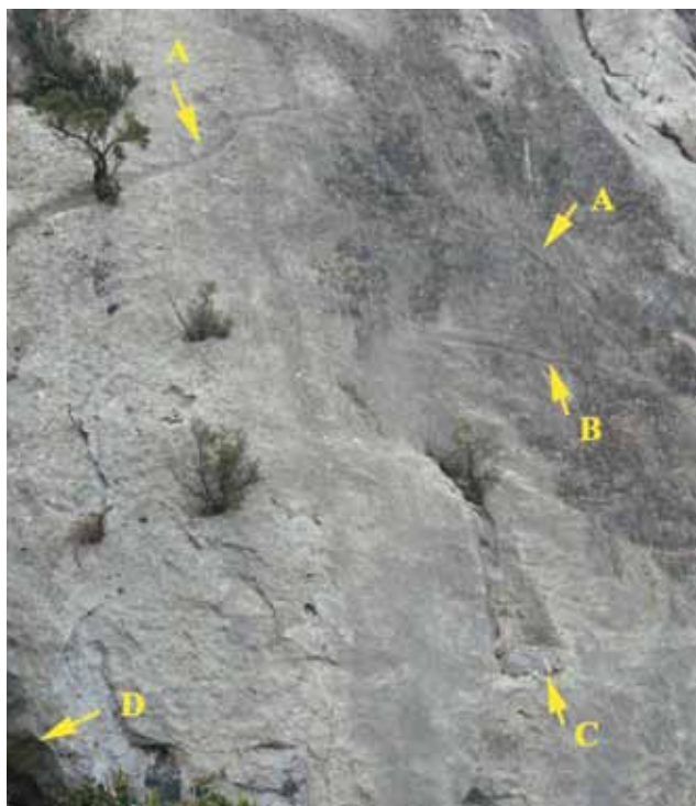
19 - Point n°15 : saignée triangulaire (A) qui protège l'ancrage d'une toiture en hauteur sur la falaise; le retour horizontal de ce larmier (B), formant triangle, paraît étrange (logement d'un plancher ?), de même que l'encoche verticale (C) avec des traces de maçonnerie et qui a pu servir de base à un pilier; latéralement (D), une large fissure est colmatée par du mortier (cliché A. Catafau).
