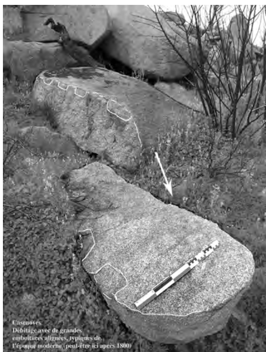
14 Carrière de Casenove, débitage du granite avec grands coins de bois, après 1793 (clichés et DAO M. Martzluff).
